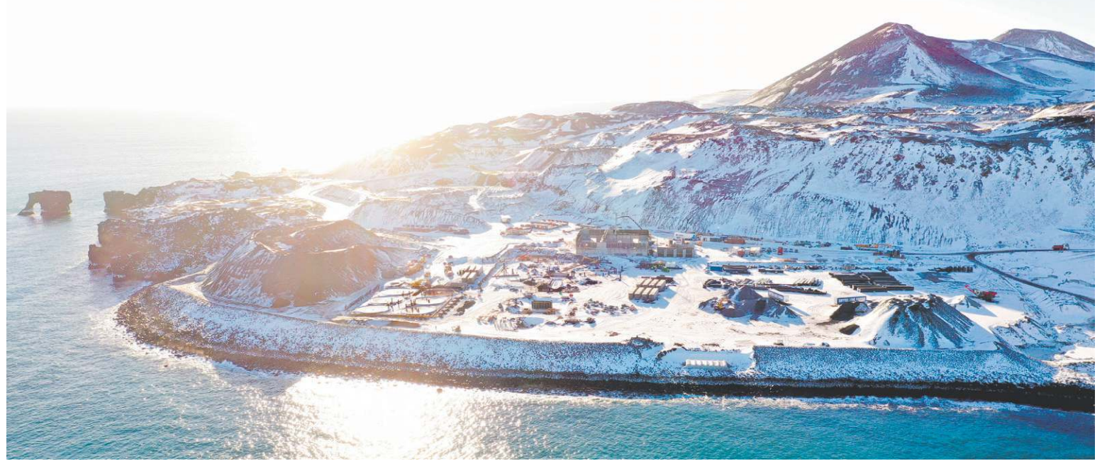
■ Bygging eldisstöðvar Laxey í Vestmannaeyjum er í fullum gangi. Borholudælur frá HD er meðal búnaðar sem þar er verið að setja upp.
