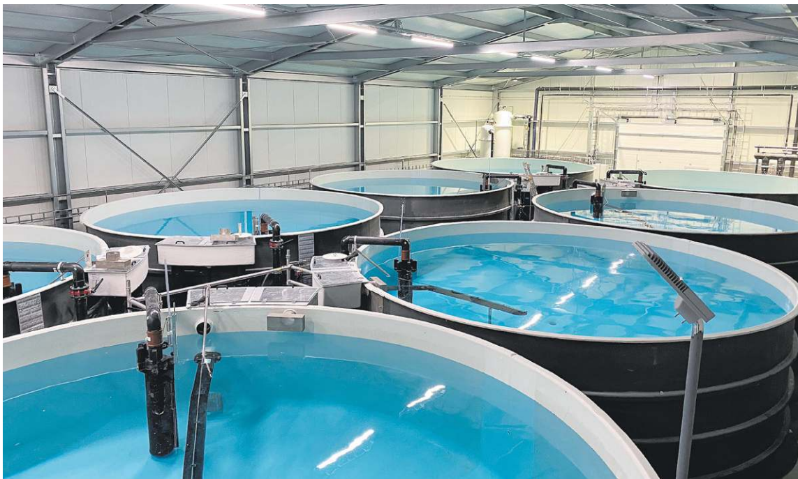
■ Hér má sjá frístandandi 6 metra fiskeldisker frá Trefjum í rekstri í seiðaðeldisstöð Arnarlax á Gileyri.
